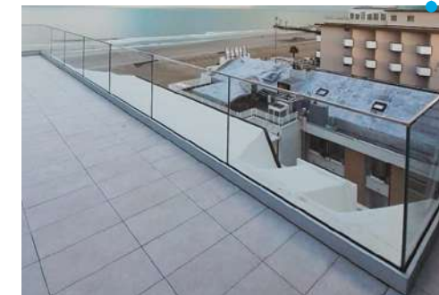
12 Parapetto a pavimento
