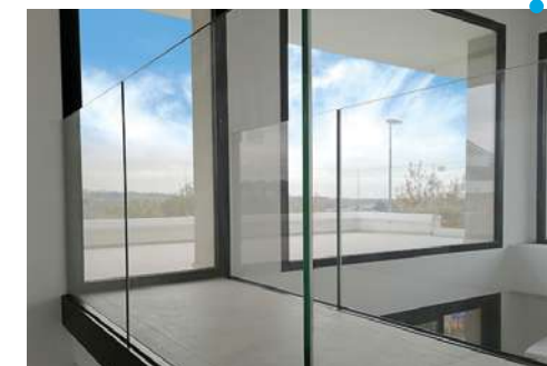
14 Parapetto fronte solaio
